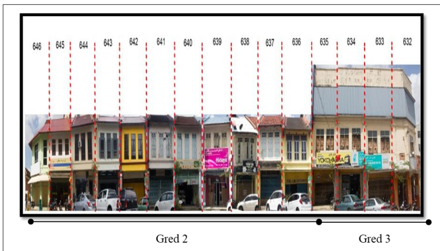
Rajah 3: Fasad Rumah Kedai Lama di Jalan Ismail Bandar Kota Bharu Kelantan
