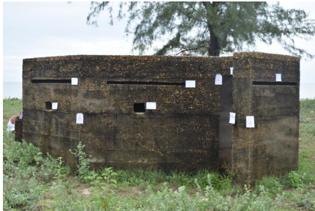
Rajah 5: Keadaan Kubu Kampung Ger, Bachok
