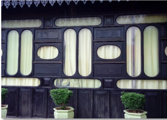
(a) Dinding bangunan
